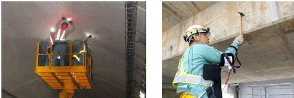
(a) 目視検査 (b) 打音検査
