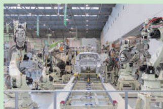
メインボデー増打ち自動溶接ライン
