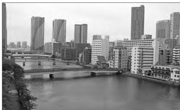
写真1 晴海中学校近隣の高層住宅
